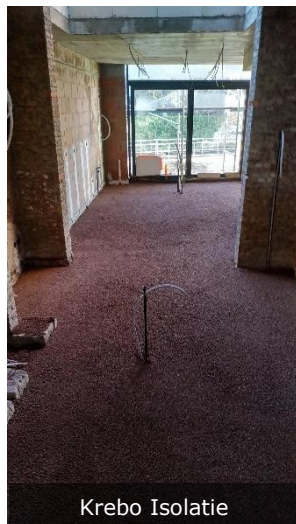
Vloerplaat met leiding
